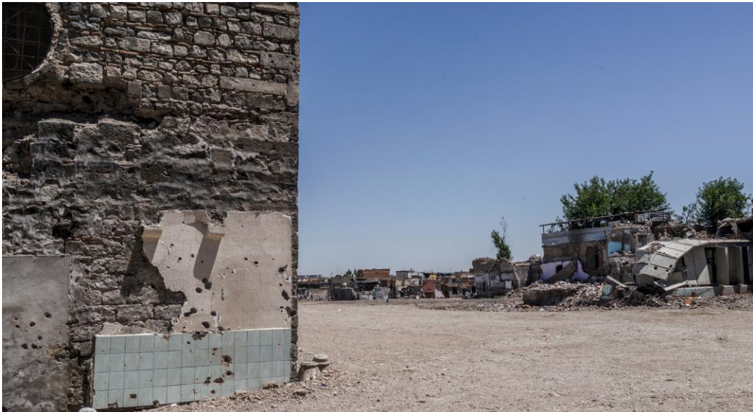
Silahlı çatışmalardan zarar gören ya da yıkılan binaların olduğu Sur'un merkez kesimleri. © Guy Martin/Panos
