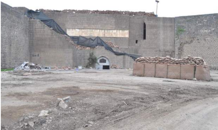
Çatışma sonrası Keçi Burcu
