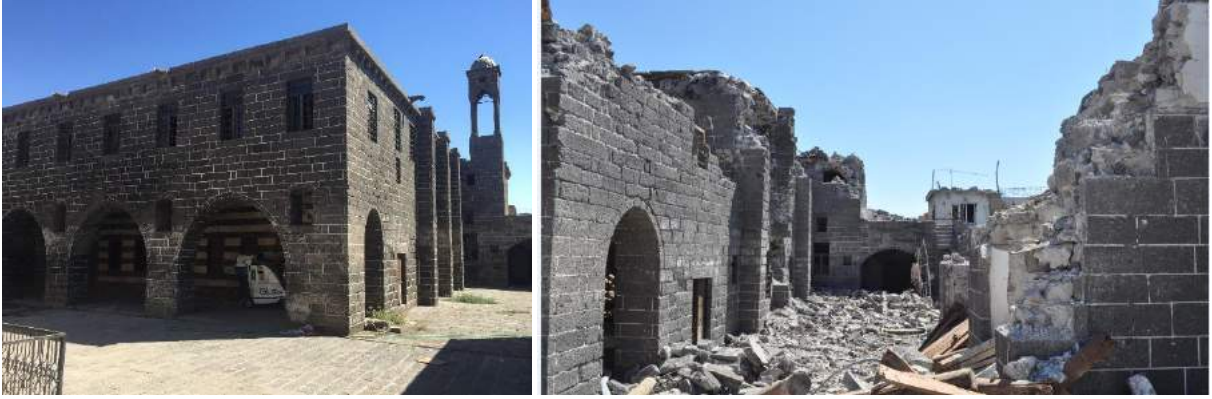
Hasırlı Mahallesi 231 ada 4 nolu parselde bulunan Ermeni Katolik Kilisesinin çatışmalar sonrası yıkılmış çan kulesi
